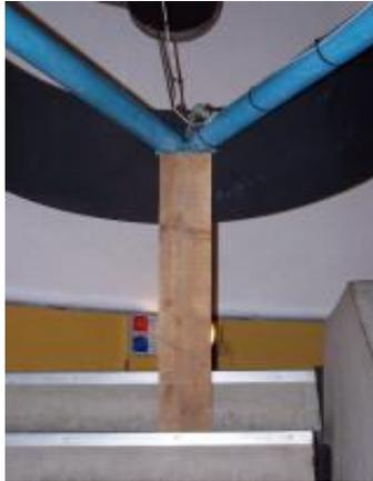
2. Fissare la carrucola ai tralicci, togliere il buffer dello specchio principale e poi del secondario quindi procedere con lo smontaggio dello specchio sec.. Terminata questa operazione fissare il tirante SUD all'anello.
