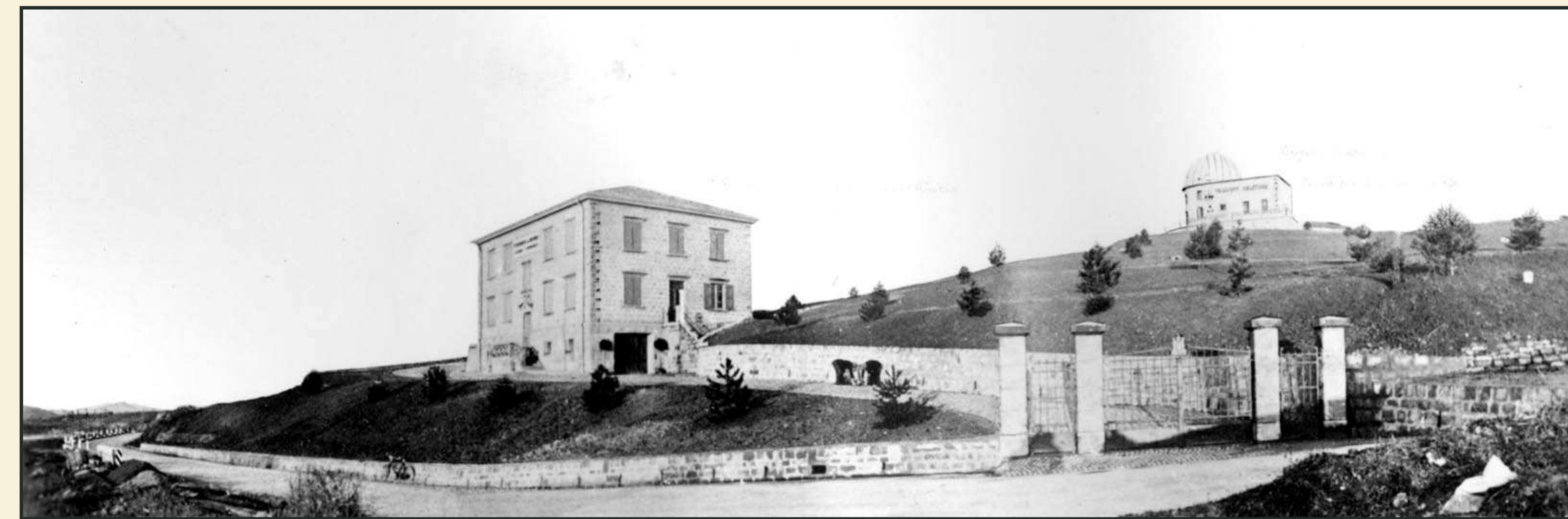
1936: finalmente terminata! (Centro di Servizi Archivio Storico, Università di Bologna)
