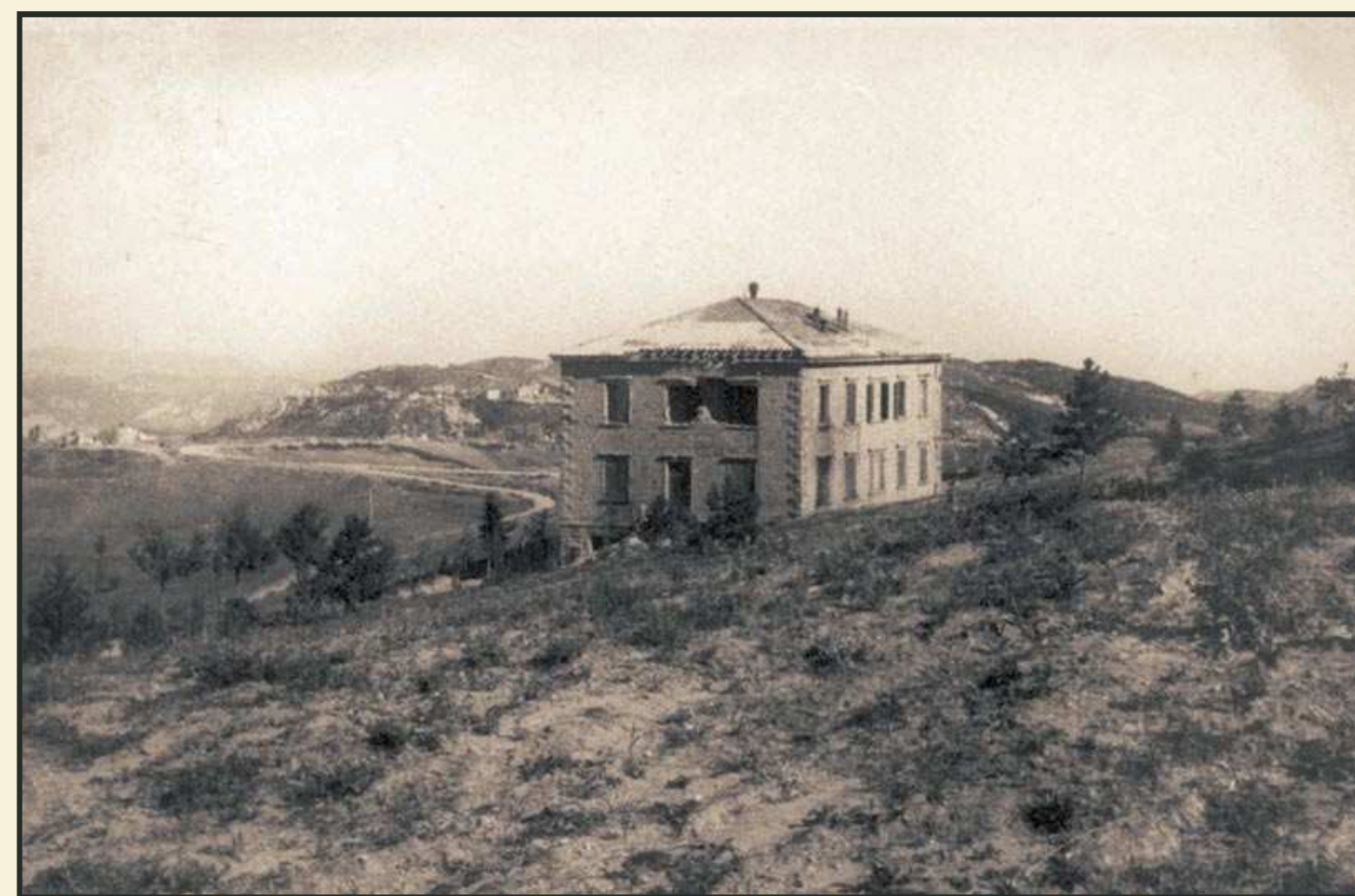
La facciata a sud della palazzina della Stazione Astronomica di Loiano colpita da un proiettile di artiglieria. (Centro di Servizi Archivio Storico, Università di Bologna)
