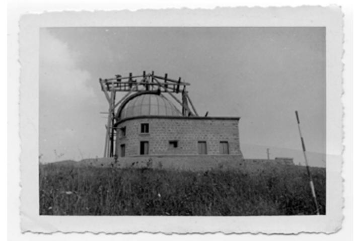
*In evidenza il ponteggio per portare la base del telescopio all'interno dell'edificio. (Centro di Servizi Archivio Storico, Università di Bologna)*
